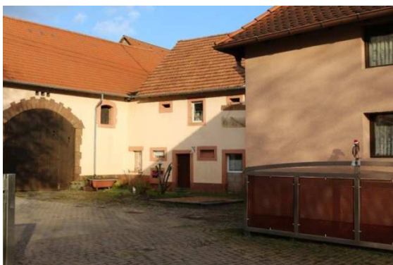
Abb. 56: Haus-Hof-Bebauung in der Zweibrücker Straße
