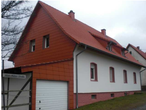
Abb. 11: Einfamilienhaus im sehr guten Zustand Ortseingang in der Adam-Müller-Straße
