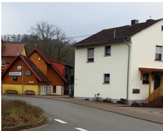
Abb. 45: Wohnhäuser in sehr gutem Zustand
