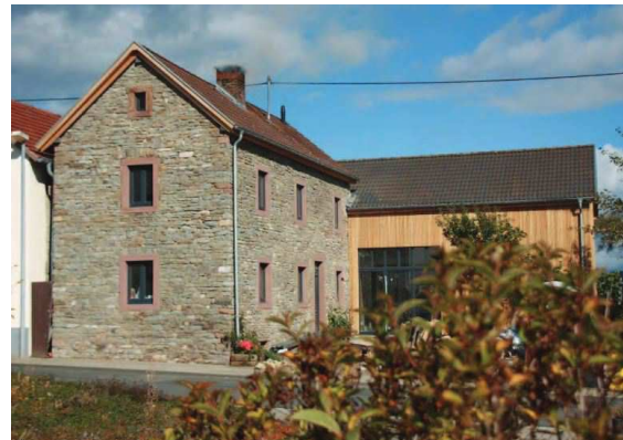
Abb. 77: Straßenansicht des umgestalteten Gehöfts
