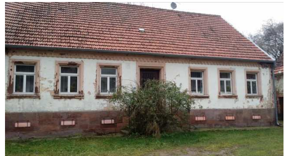
Abb. 47: Wohnhaus in einem befriedigendem Zustand
