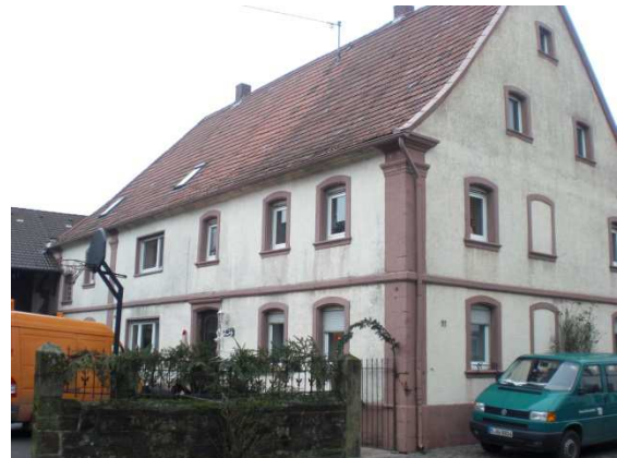
Abb. 13: Haus-Hof-Bebauung im befriedigenden Zustand
