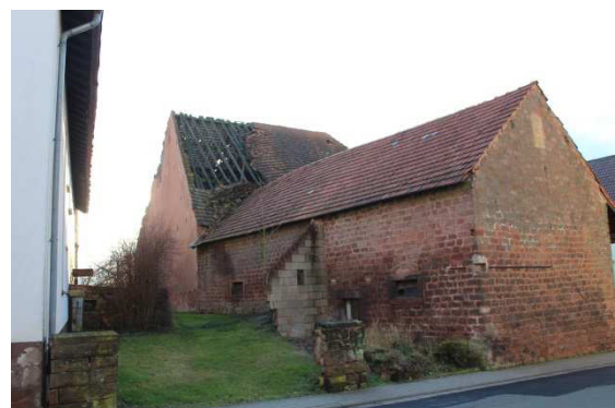
Abb. 65: Gebäude im schlechten Zustand
