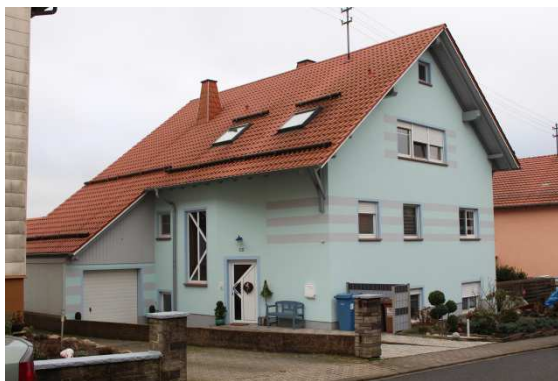
Abb. 63: Gebäude im guten bis sehr guten Zustand
