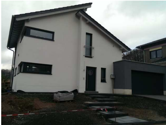
Abb. 40: ortsbilduntypisches Einfamilienhaus in neuer Siedlung
