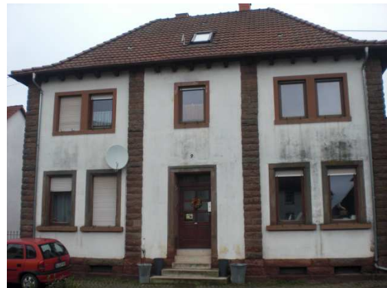
Abb. 14: Einfamilienhaus im befriedigenden Zustand
