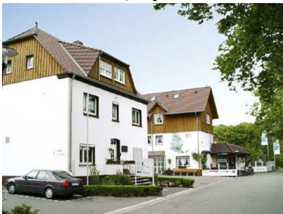
Abb. 103: Das Müller Haus vor und nach der Umnutzung
