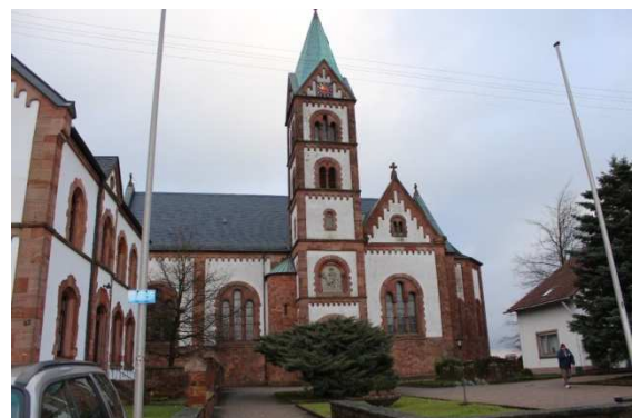
Abb. 62: Denkmalgeschützte Kirche und Pfarrgebäude in der Zweibrücker Straße
