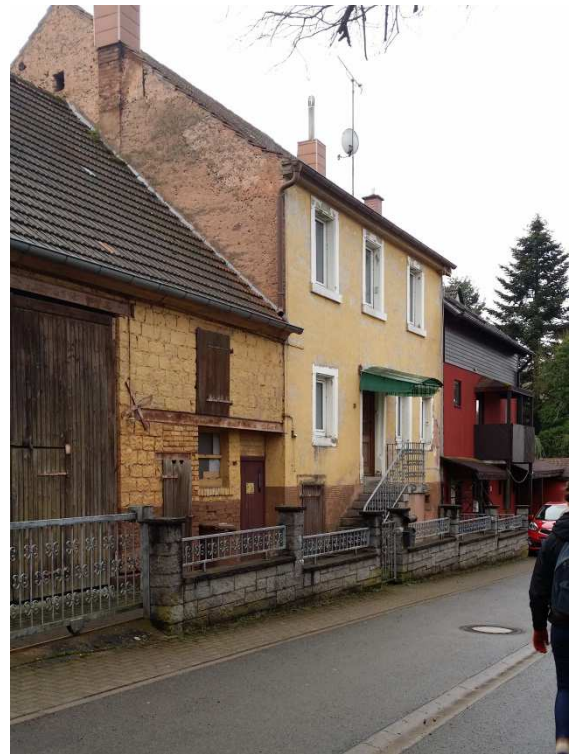
Abb. 46: Einfamilienhaus in befriedigendem Zustand in der Eckstraße
