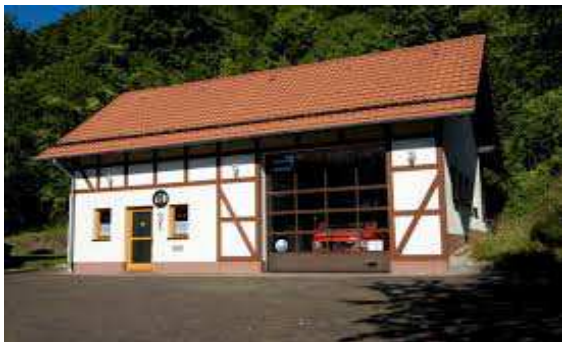
Abb. 110: Scheune als Feuerwehr
