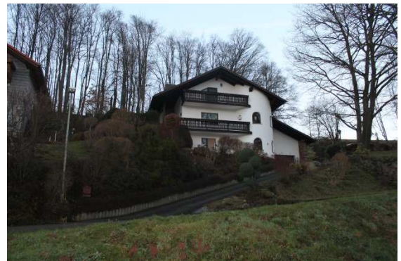
Abb. 33: Einfamilienhaus in sehr gutem Zustand
