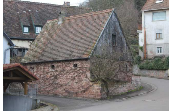
Abb. 32: Denkmalgeschütztes Gebäude Hauptstraße 7
