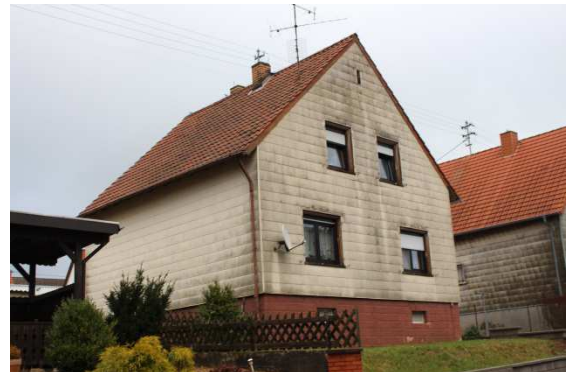
Abb. 64: Gebäude im befriedigten Zustand
